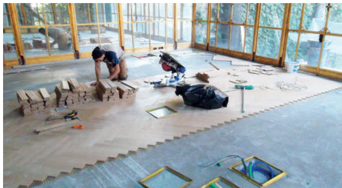
ripristino delle pavimentazioni lignee
