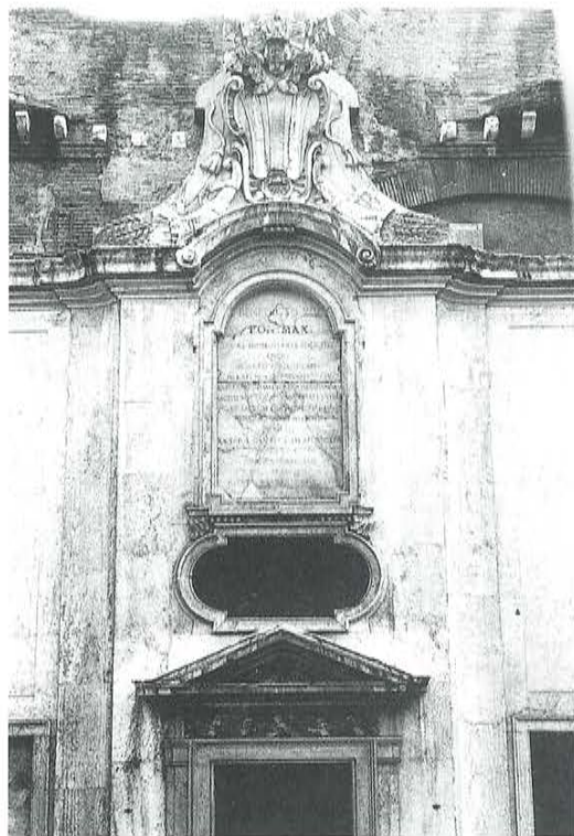
Fig. 12. Dettaglio della porzione centrale della facciata dell'oratorio con i raccordi curvi che la mettono in risalto rispetto alle parti laterali.
