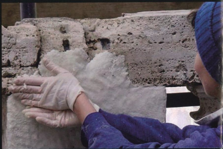
• La "loggia di Maria Casimira" sulla piazza di Trinità dei Monti e gli interventi di restauro degli elementi in travertino
