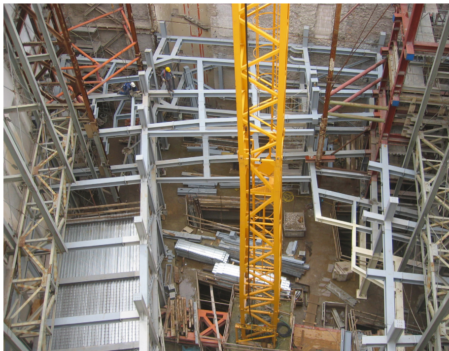
5 Nuova Biblioteca Hertziana: sul piano trave in calcestruzzo armato si assembla la struttura in acciaio e si smontano progressivamente quelle provvisorie (foto studio Da Gai)
