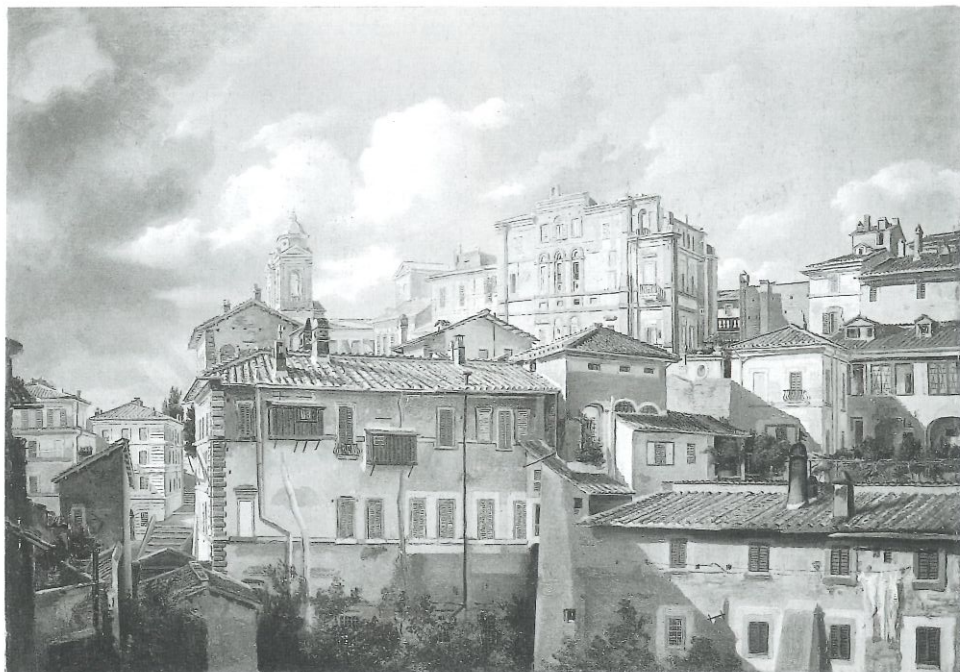
Il fianco di palazzo Zuccari in una rara angolazione visiva; si scorge la facciata laterale e il grande vuoto sul giardino nel quadro del pittore E. N. Neureuther del 1837.
