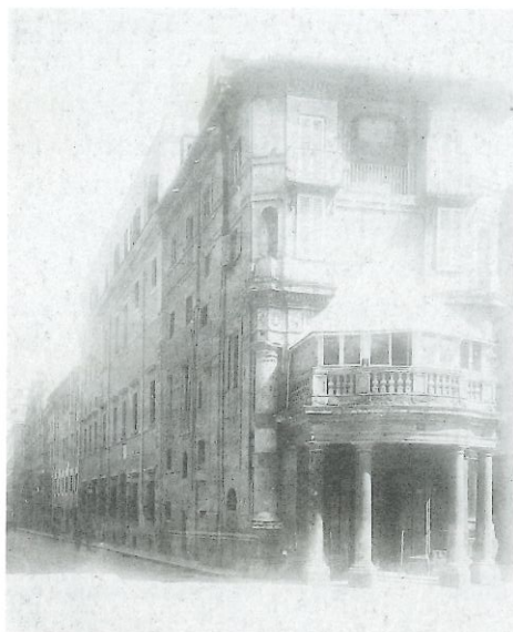
Il tempietto su piazza Trinità prima delle trasformazioni fatte realizzare da Henriette Hertz.
