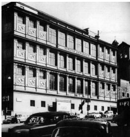
FIG. 1 FACCIA DELL'EDIFICIO DELL'UFFICIO GEOLOGICO IN UNA FOTO D'EPOCA, VISTA DA LARGO S. SUSANNA, ROMA.
