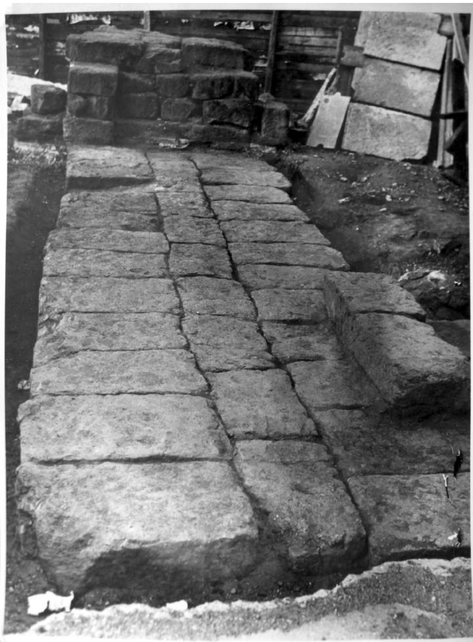
FIG. 16 FOTOGRAFIA DEL MURO RINVENUTO DA GUGLIELMO GATTI (DA ACS, ARCHIVIO GATTI , FASC. 7, REGIONE VI, FOGLIO 2235).
