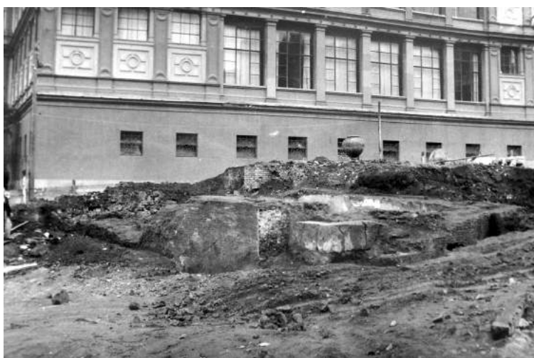
FIG. 20 FOTOGRAFIA PANORAMICA DELLE STRUTTURE ROMANE RINVENUTE NELL'ATTUALE LARGO DI S. SUSANNA; SULLO SFONDO LA FACCIAIA DELL'EX REGIO UFFICIO GEOLOGICO (DA ACS, ARCHIVIO GATTI, FASC. 7, REGIONE VI, FOGLIO 2231).
