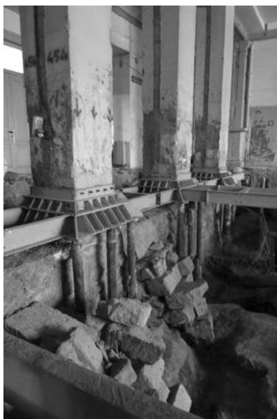
FIG. 3 SISTEMA DI MESSA IN SICUREZZA STATICA DELL'EDIFICIO.
