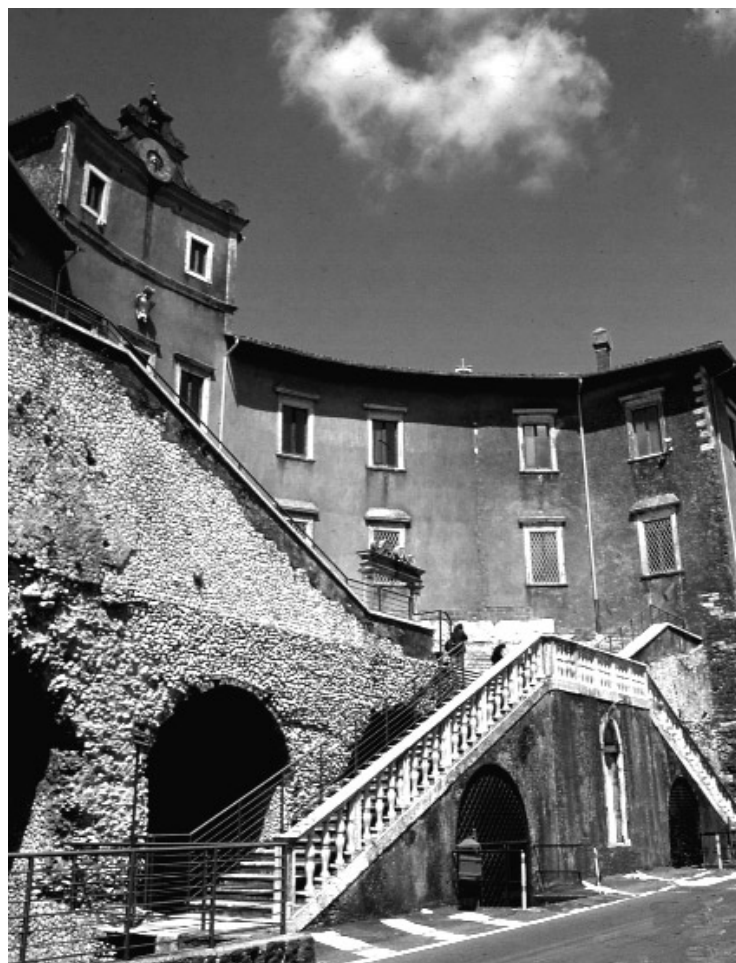
Fig. 20. Viste di scorcio del granaio di Urbano VIII (sopra) e del palazzo Colonna-Barberini a Palestrina.
